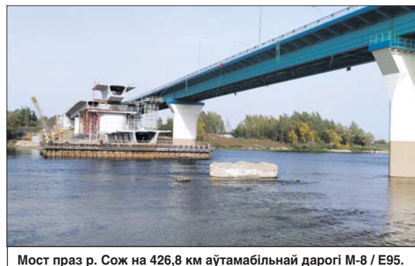
Мост праз р. Сож на 426,8 км аўтамабільнай дарогі М-8 / Е95.
