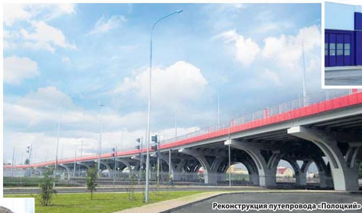
Реконструкция путепровода «Полоцкий»
